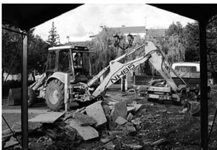
El 31 de octubre comenzaron las obras de transformación de la plaza del Dr. Vicente, con las excavaciones para el solado de dicho espacio público. Las obras van a consistir en el cambio de la pavimentación que irá con bandas de piedra blanca combinada con paños de hormigón negro rayado, apertura de nuevas entradas para la plaza (hoy sólo posee dos), y la eliminación del seto, manteniendo eso sí, su carácter ajardinado y peatonal.
