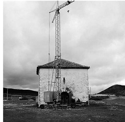
edificio en 1995: forjados y cubierta. Dado que se trata de una obra prospectiva, también se van a picar las paredes a fin de descubrir las huellas de posibles estructuras antiguas, especialmente apoyo de vigas y escaleras. Se trata de una obra subvencionada con 12.000 euros por la Consejería de Cultura.
